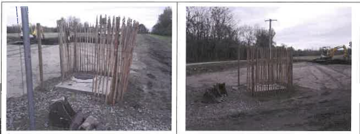
Travaux de sécurisation du puits de lixiviats en cours
