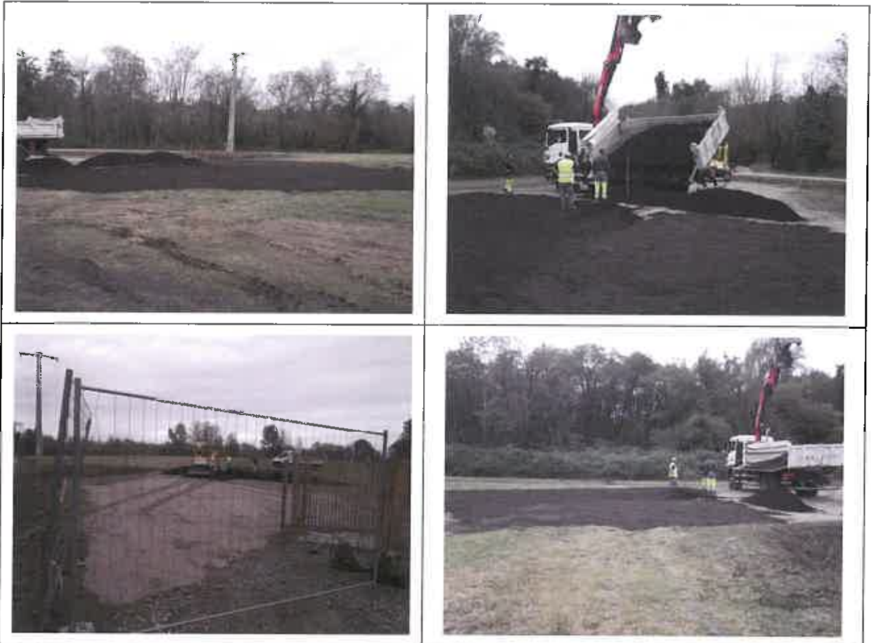
Travaux des réhabilitation en cours
